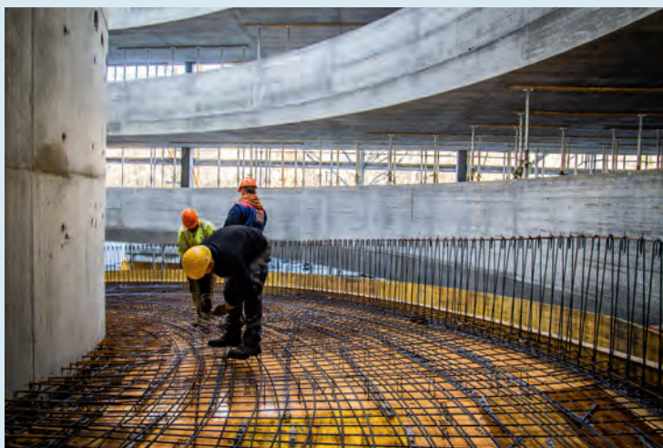
Ouvriers sur le chantier en février 2019.
